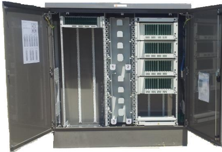
PM de capacité 576 fibres distribuées (360 locaux desservis)
